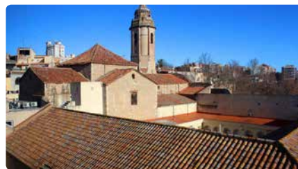
Valls invertirà 434.000 euros per a la millora de l'església de Sant Francesc DV, 12/06/2020 | EL VALLENC
