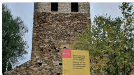
Comencen les obres d'estabilització del monestir de Sant Miquel de Cruïlles DC, 24/11/2021 | DIARI DE GIRONA
